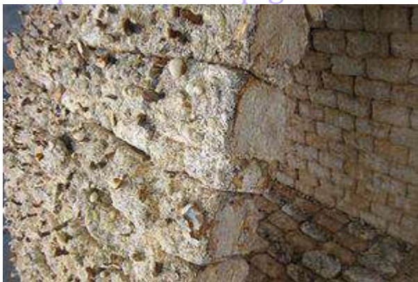
Construction en briques de mycélium de champignon.
